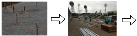
地中に杭を打ち込みます。 → 単管パイプをパイプクランプで組上げます。 →
